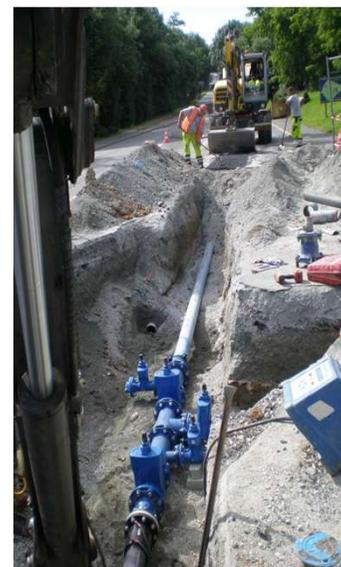
Ouverture de tranchée pour pose de conduite d'eau potable à la trancheuse – 1 Km par jour
