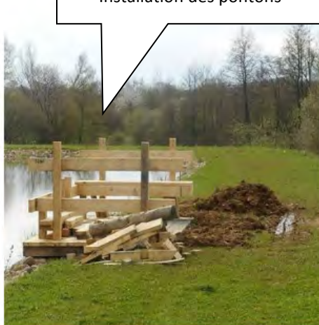
Installation des pontons
