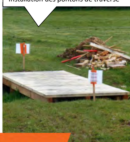
Installation des pontons de traverse
